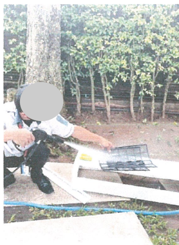
รูปภาพที่ 2.20 การล้างทำความสะอาดเครื่องปรับอากาศ
