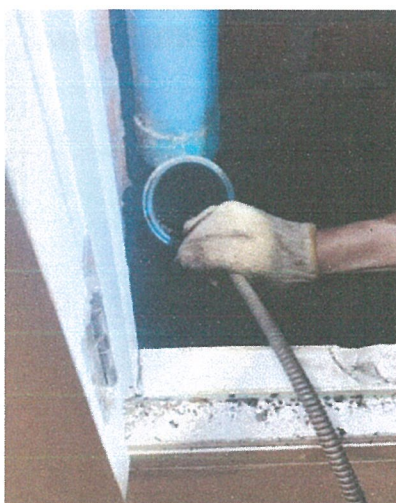
รูปภาพที่ 2.25 การตรวจสอบเส้นท่อจ่ายน้ำ
