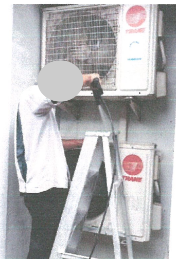
รูปภาพที่ 2.20 การล้างทำความสะอาดเครื่องปรับอากาศ
