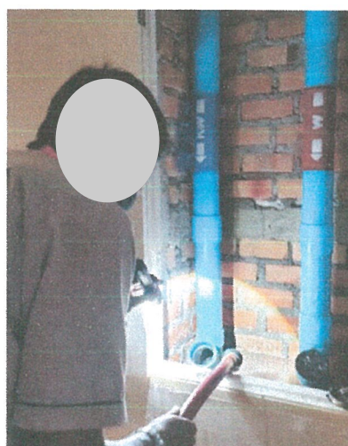
รูปภาพที่ 2.25 การตรวจสอบเส้นท่อจ่ายน้ำ
